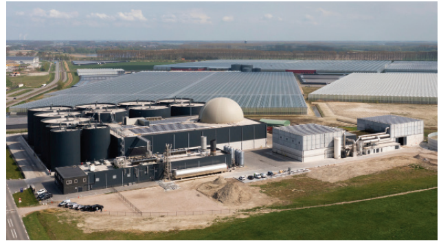
Usine de méthanisation SFP Zeeland située à Westdorpe (Pays-Bas)
